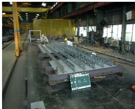
写真-1 パネル組立状況
