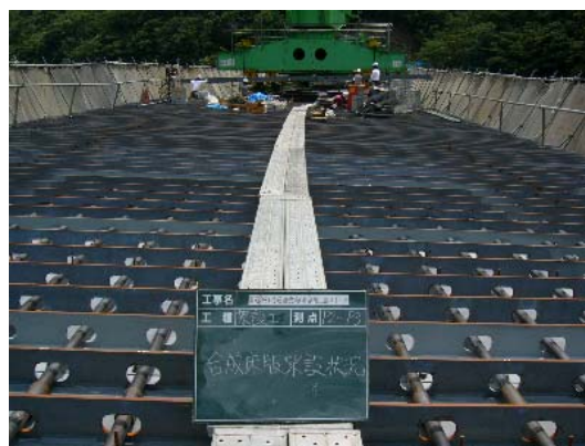
写真-3 パネル設置状況
