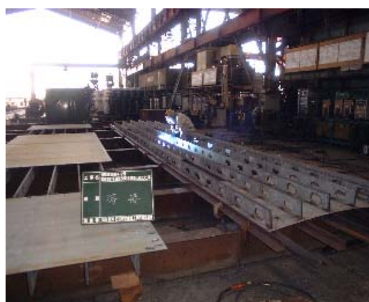
写真-2 パネル溶接状況
