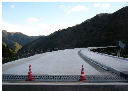
写真-4 コンクリート打込み完了
