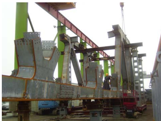
仮組立状況（面組立部材）
