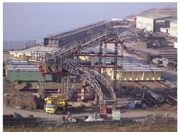
図-10 仮組立状況
