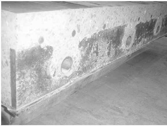
写真-3 試験体切断状況
