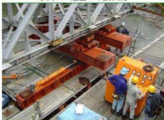
写真-2 重量物移動装置
