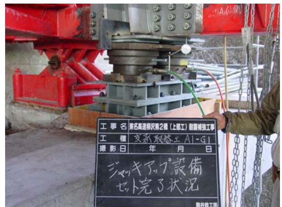
写真-2 ジャッキ配置完了
