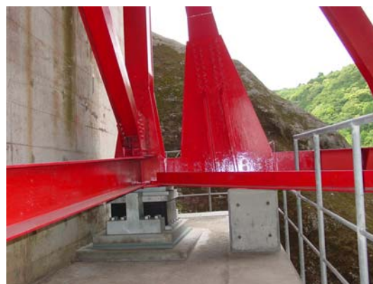
写真-3 支承取替完了
