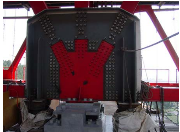
写真-1 ジャッキアップ補強部材
