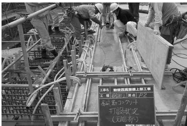
写真-5 高流動コンクリート打設状況
