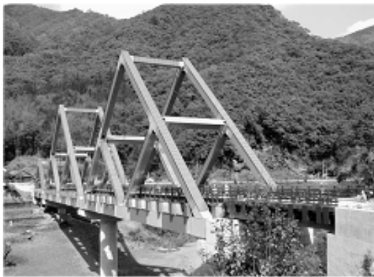
写真-13 完成写真
