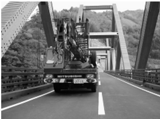
写真-14 載荷試験状況
