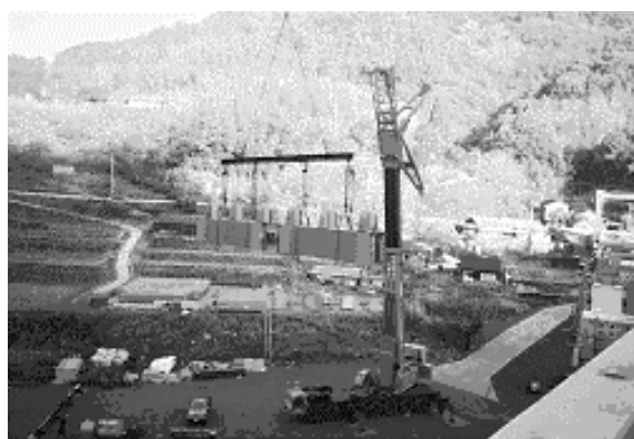
写真-8 下弦材の架設
