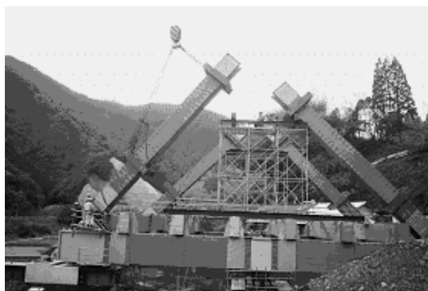
写真-10 下段上弦材の架設
