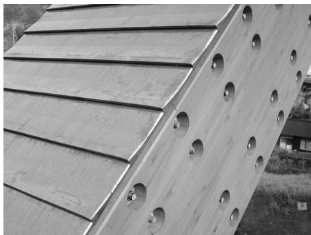
写真-11 上弦材水切り銅板設置状況
