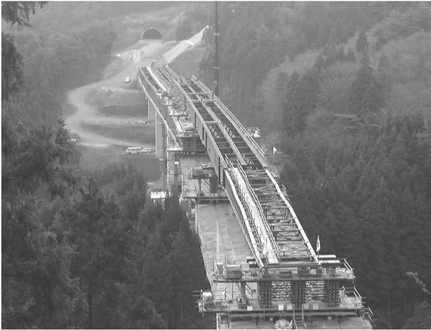
写真-2 3主桁送出し状況
