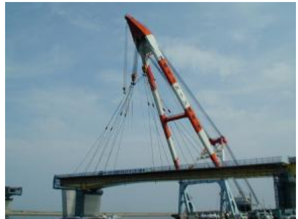
写真-4 地蔵浜側ブロックの架設
