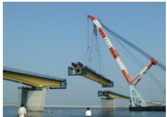
写真-5 中央径間ブロックの架設
