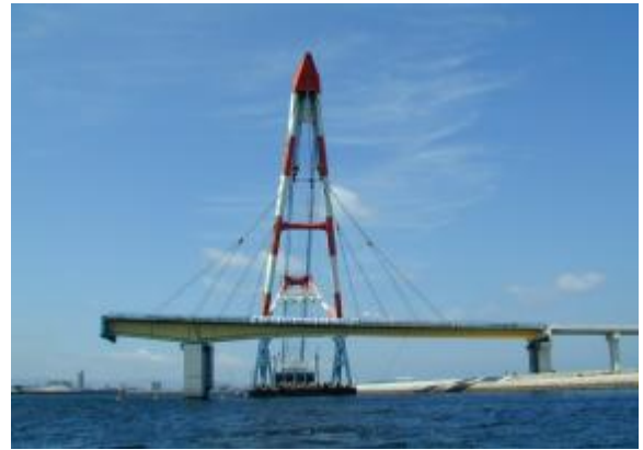
写真-3 阪南2区側ブロックの架設
