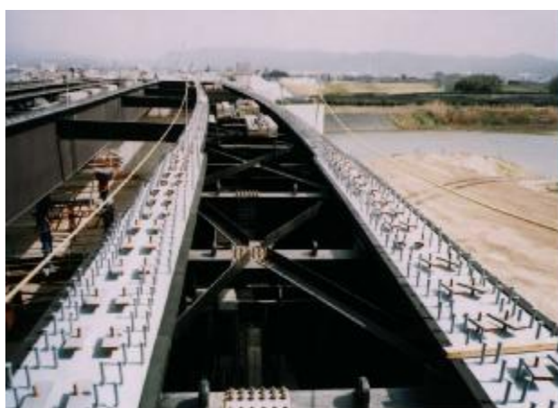
写真-1 上横構設置状況
