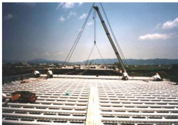
写真-3 合成床版パネル設置状況
