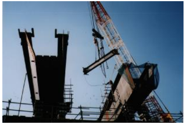
写真-2 桁架設状況
