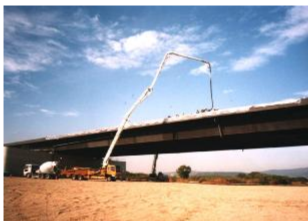
写真-4 合成床版コンクリート打設状況
