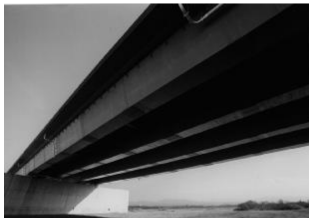
写真-5 橋梁下面
