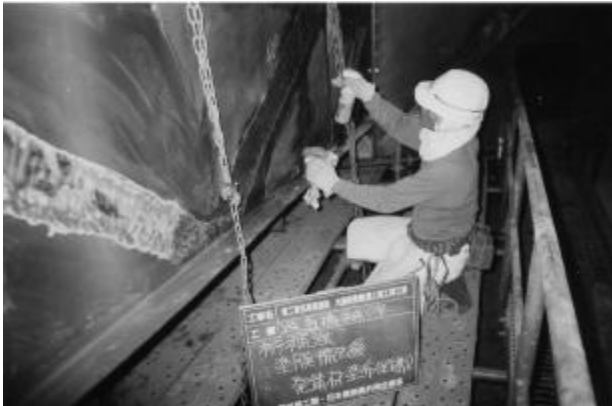
写真-6 錆促進剤塗布状況
