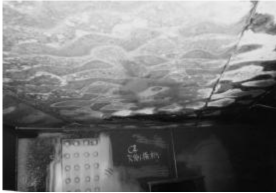
写真-3 グレーチング床版下面
