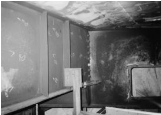
写真-4 塗装焼化状況
