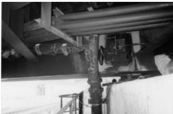
写真-5 排水管（VP管）溶融状況
