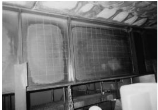
写真-2 鋼部材の面外変形
