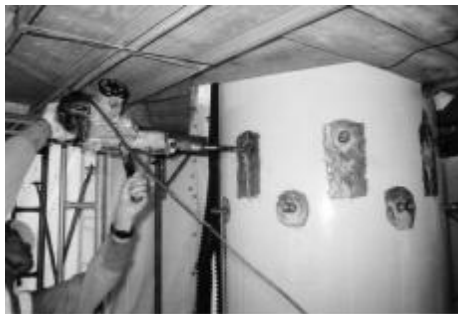
写真-2 アンカー施工状況
