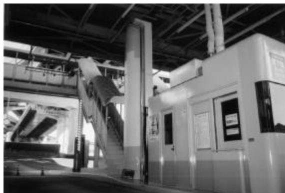
写真-5 施工完了
