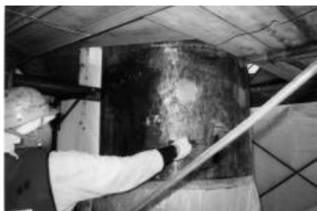
写真-3 プライマー塗布状況
