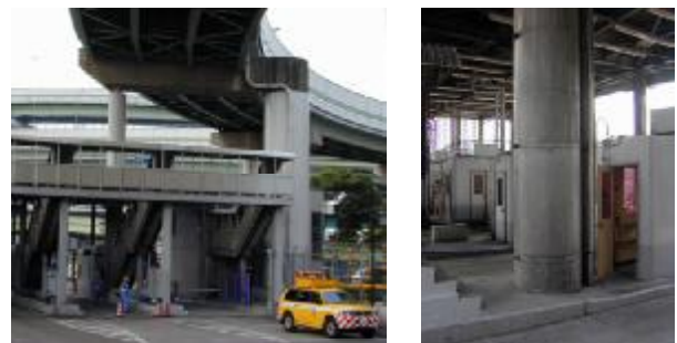
写真-1 天保山入 P3 橋脚
