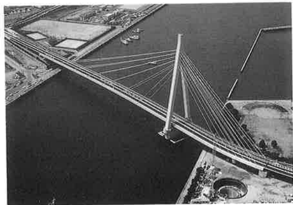
写真-1 常吉大橋全景
