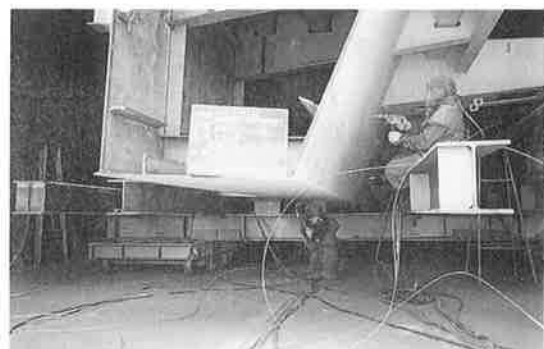
写真-5 アルミ溶射 (工場施工)
