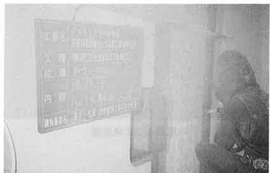
写真-6 アルミ溶射 (ヤード施工)
