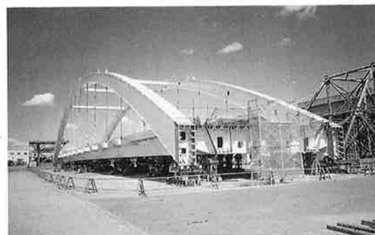
写真-11 地組立(中央径間部分のみ)
