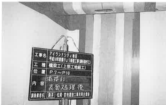
写真-2 サンドブラスト後 (ヤード施工)
