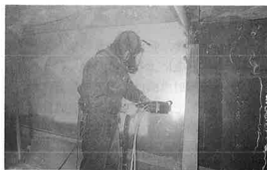
写真-3 アルミ亜鉛溶射工
