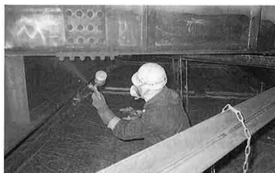
写真-2 粗面化処理工
