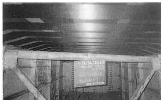
写真-1 炭素繊維シート補強
