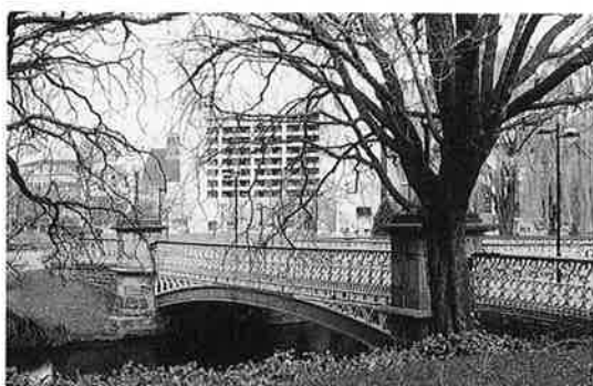
写真-6 ビクトリア橋
