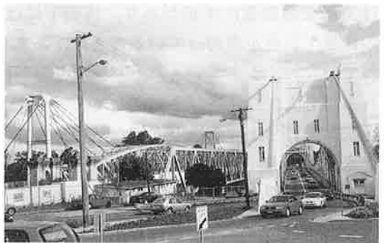
写真-4 テイラー橋
