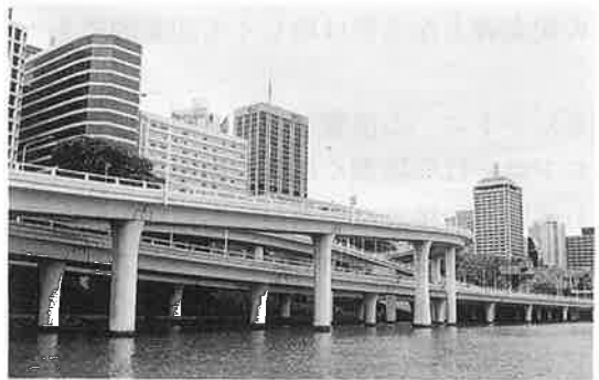
写真-3 都市高速道路橋
