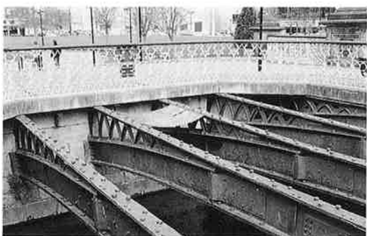
写真-7 ビクトリア橋の構造部材
