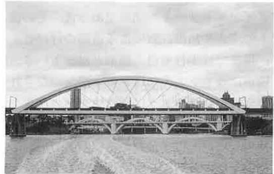
写真-2 メリベイル鉄道橋
