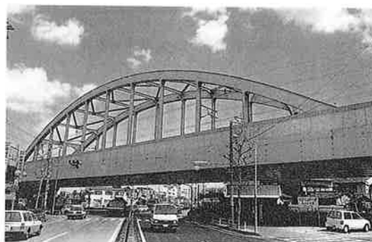
写真-9 東海道新幹線 第2六番町架道橋 (下路ローゼ橋, 昭和39年架設)
