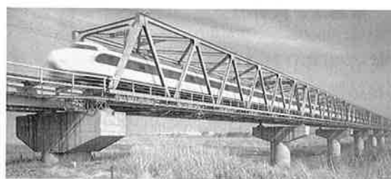
写真-5 東海道新幹線 相模川橋梁 (3径間連続下路ワーレントラス橋、 スパン 3 \times 60.0 = 180.0\text{m} )
