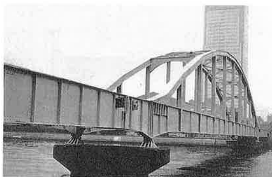
写真-8 東京都専用線 豊洲橋梁 (下路ランガー橋, 昭和28年架設)
