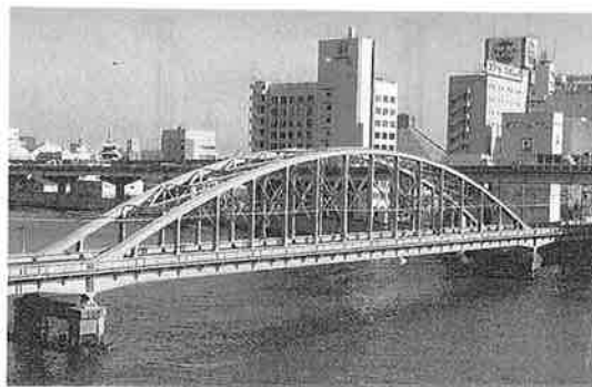
写真-7 総武線 隅田川橋梁 (下路ランガー橋, 昭和7年架設)
