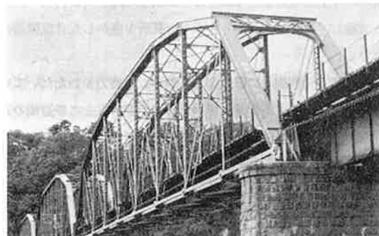
写真-4 アメリカ系トラス橋（シュエドラー型）
