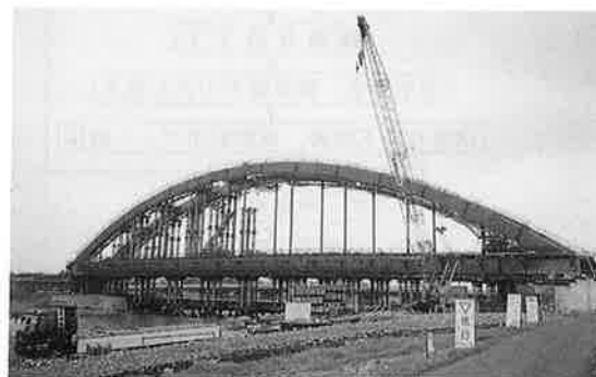
写真-10 補剛桁上仮設備解体状況
