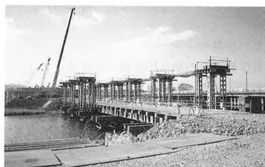
写真-5 補剛桁用ベント
