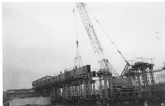
写真-7 補剛桁架設状況
