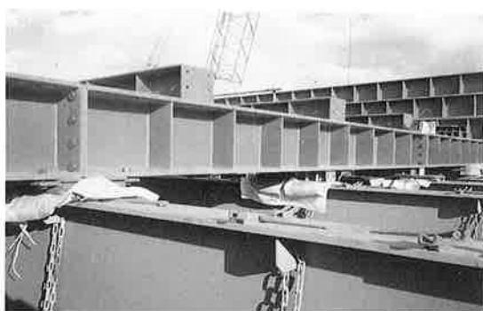
写真-3 作業構台床組
