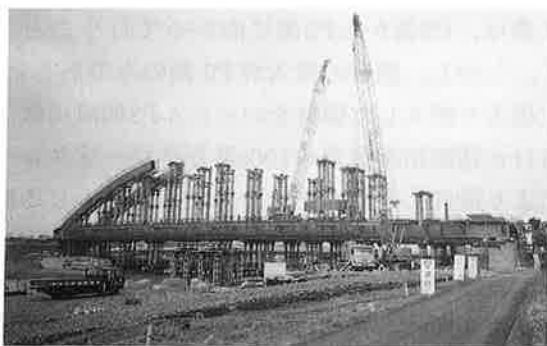
写真-8 アーチリブ架設状況
