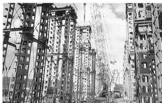
写真-6 アーチリブ用ベント
