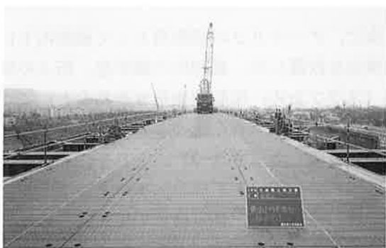
写真-4 作業構台上面
