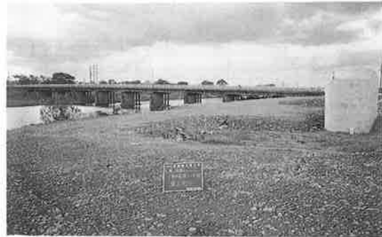
写真-1 搬入路の状況
