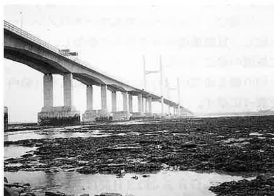
写真-1 川底より見た第2セバーン橋
