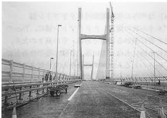
写真-2 第2セバーン橋（急ピッチで施工中の斜張橋）
