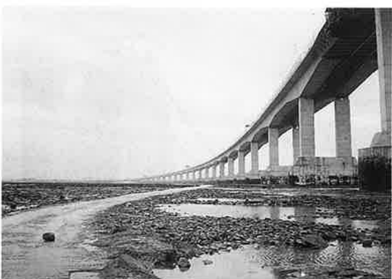
写真-4 第2セバーン橋（中央付近から岸を望む）
