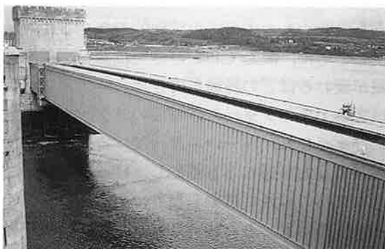
写真-17 コンウェイ鉄道橋(箱桁橋)(箱桁の中を鉄道が通っており、線路は外からは見えない。コンウェイ城への配慮)
