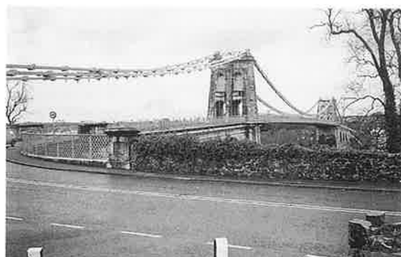
写真-15 メナイ吊橋(吊橋)(テelfordの施工で設計計算なし。側径間は石積アーチ)
