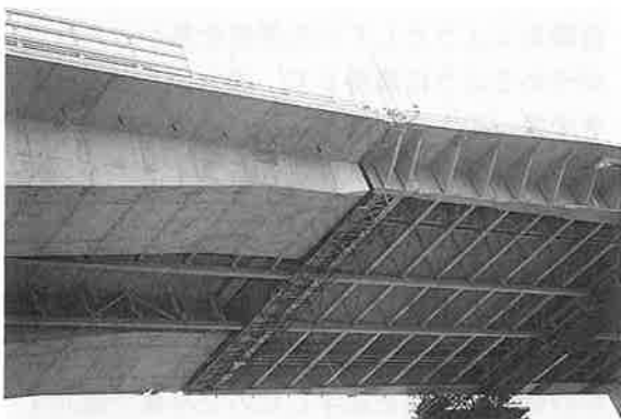
写真-3 第2セバーン橋（下からみた斜張橋）
