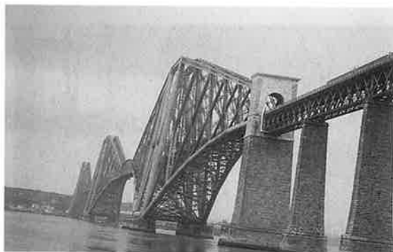
写真-13 フォース鉄道橋(トラス橋)(下弦材はアーチを思わせるカンチレバートラス)
