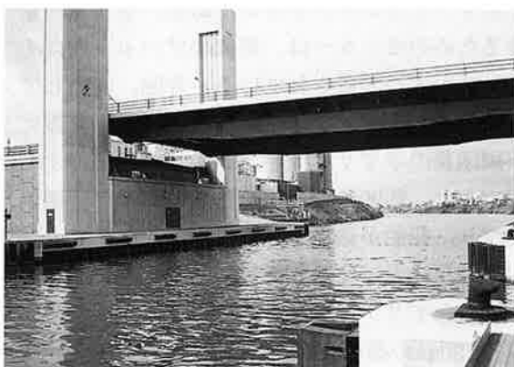
写真-9 センテナリー橋（吊り上げ中）
