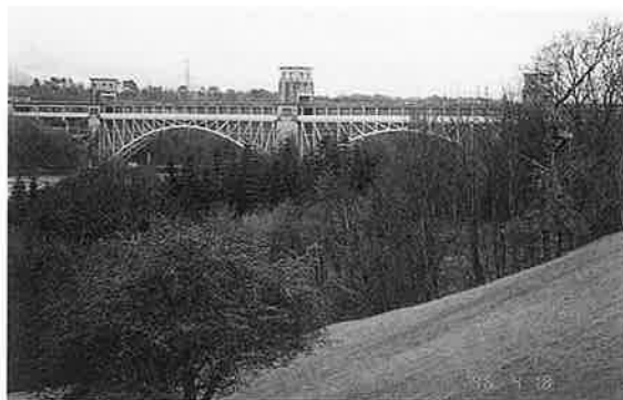
写真-16 ブリタニア橋(アーチ橋)(箱桁であったが、キャンプの火がもとで火災にあい、現在のアーチ橋となった)
