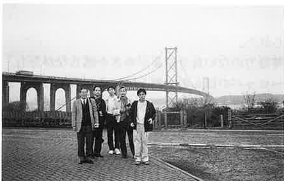
写真-14 フォース道路橋(吊橋)(エアスピニングによる平行線ケーブルを使用している)
