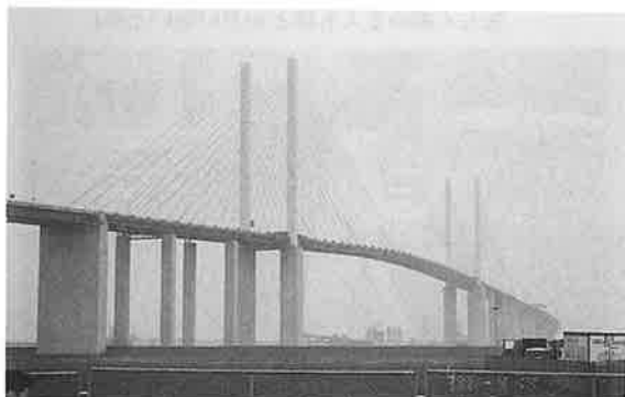
写真-12 クイーンエリザベス二世橋(斜張橋) (テムズ川に架かる。塔は梁の無い独立性)
