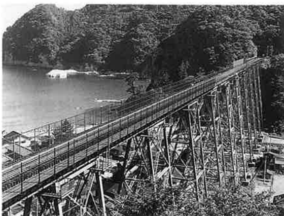
写真-2 1911年架設 山陰本線・余部高架橋の全景
