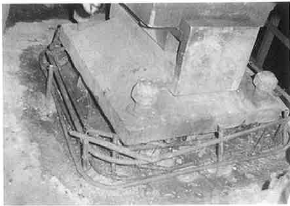
写真-7 沓座補修 補強鉄筋の組立施工例
