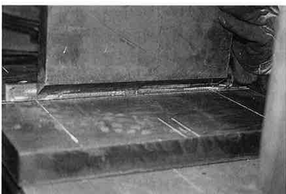
写真-11 ビルトアップH材組立完了開先面
