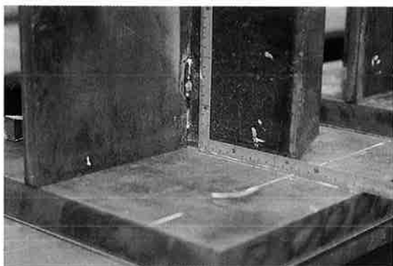
写真-9 ビルトアップH材裏当て金取付前
