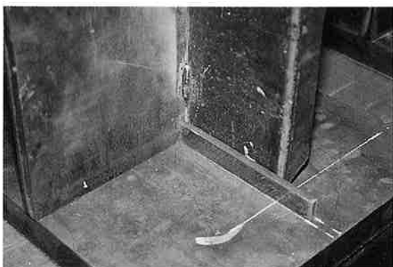
写真-10 ビルトアップH材裏当て金取付時
