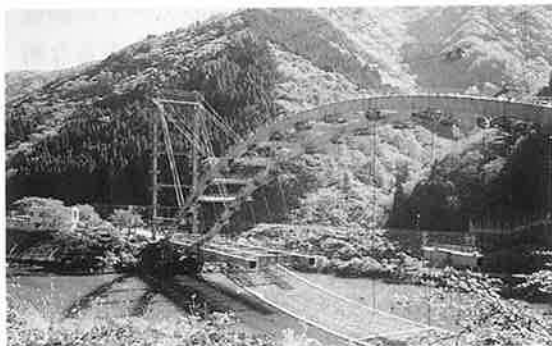
写真-3 補剛桁の架設
