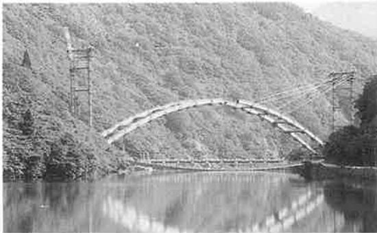
写真-2 アーチの架設
