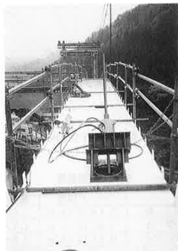
写真-4 ケーブルの引き込み
