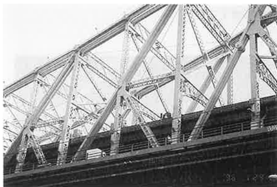
写真-10 クィーンズボロ橋(主構部)
