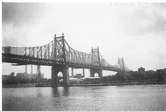
写真-9 クィーンズボロ橋
