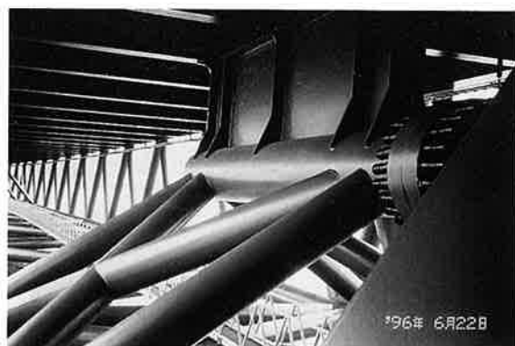
写真-5 フレキシブルロッド固定構造
