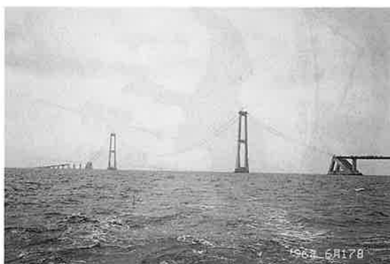
写真-1 グレートベルト吊橋
