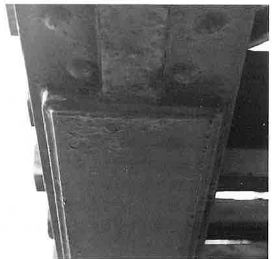
写真-1 下フランジの溝型溶接補強の施工例
