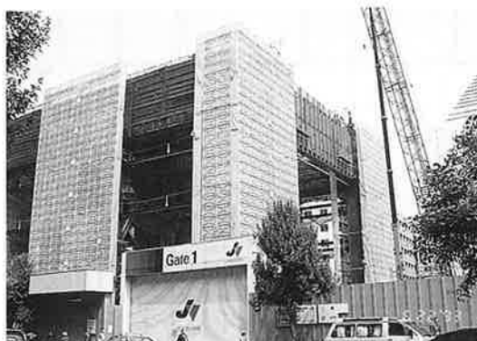
写真-6 スーパービームの建方(リフトアップ工法)
