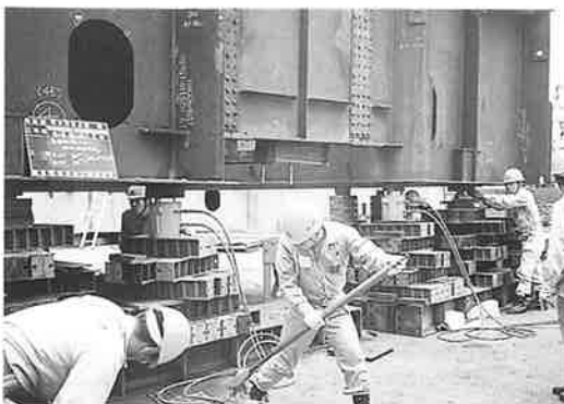
写真-2 ジャッキ操作
