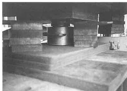
写真-3 ロードセル設置
