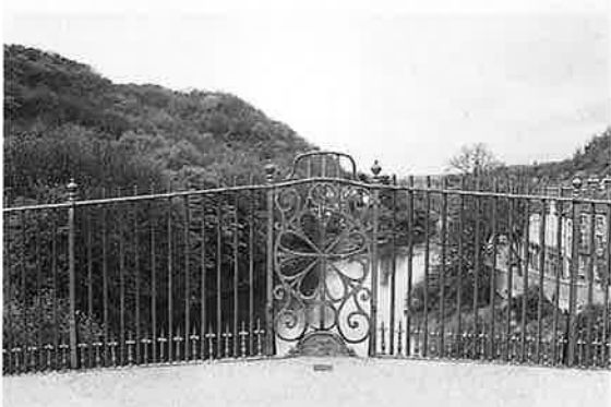
写真-7 高欄の模様(支間中央部)
