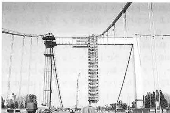
写真-28 主塔 (左側：拡幅部、右側：現橋部)
