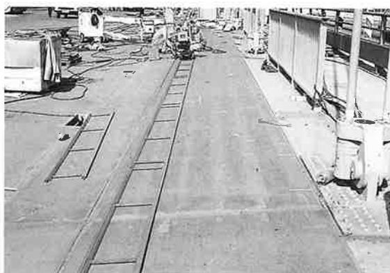
写真-29 鋼床版 (拡幅部)
