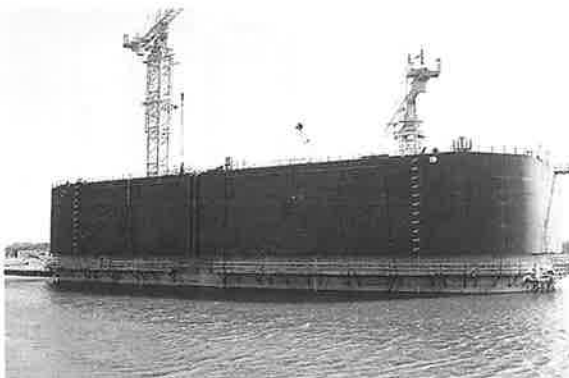
写真-23 主塔基礎のケーソン
