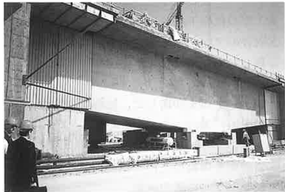
写真-25 コンクリートブロック製作ヤード
