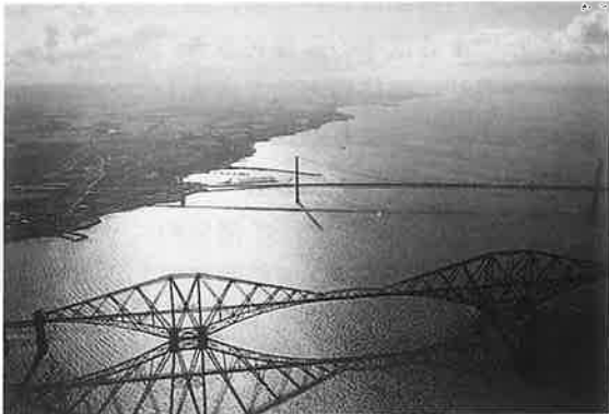
写真-8 フォース橋 (手前側：鉄道橋, 向こう側：道路橋)
