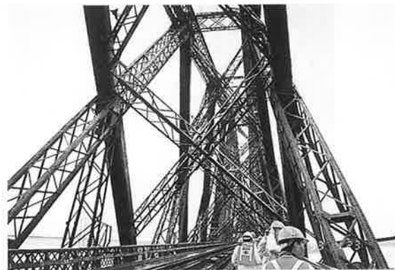
写真-11 フォース鉄道橋の内部
