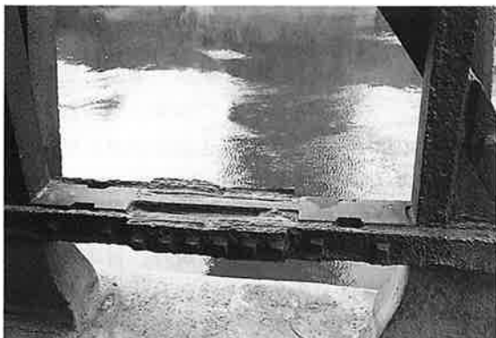
写真-6 アーチリブ支点部
