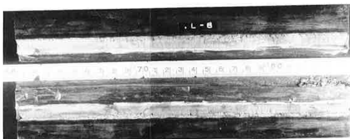
写真-5.2 破面試験結果の一例 部分溶込みかど溶接 (ガセット部)
