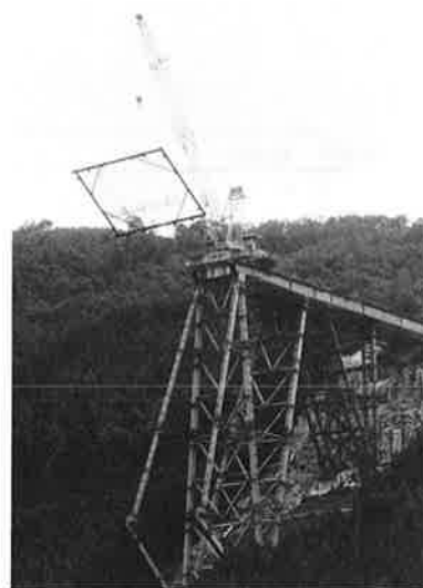
写真-2 B1・B2ベント・20t吊りT/c 移動防護工
