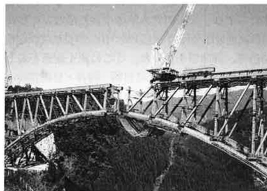
写真-1 架設状況
