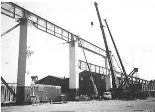
写真-3 上部工架設（工場部）
