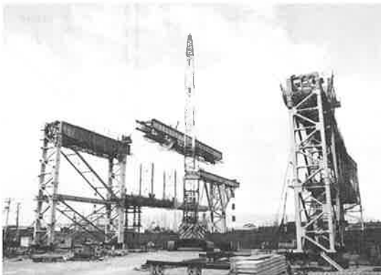
写真-2 上部工架設（搬出部）
