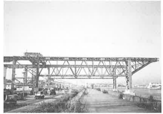
写真-5 搬出設備遠景
