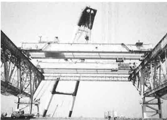
写真-4 クレーン上架
