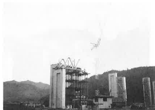
写真-2 下回り架設
