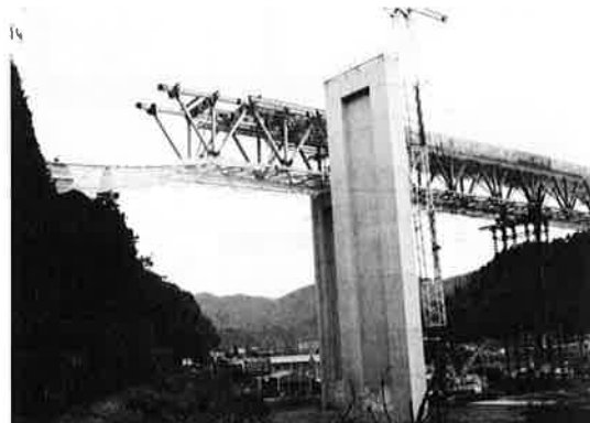
写真-8 鉄道上の架設
