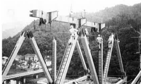
写真-3 上回りの架設
