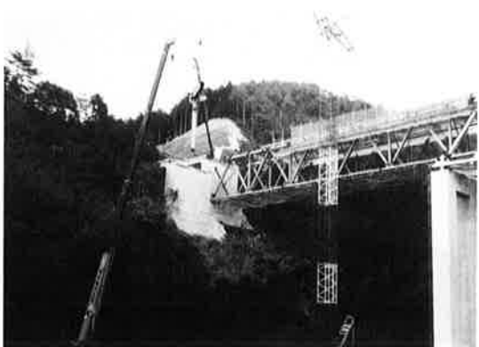
写真-6 P4~A4間の架設
