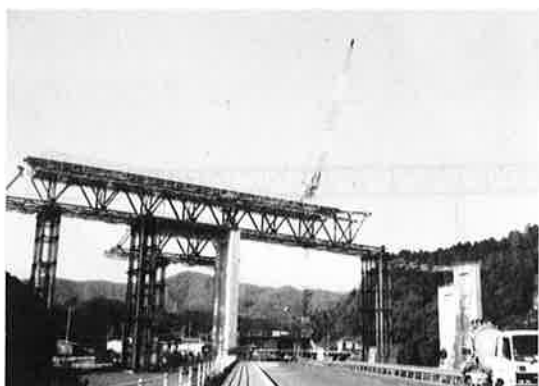
写真-5 道路上架設完了
