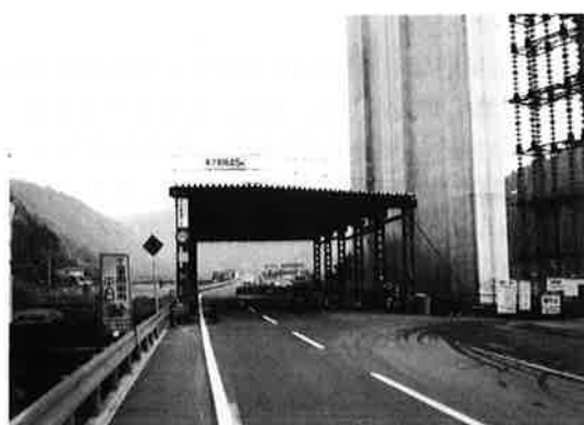
写真-10 県道上防護柵
