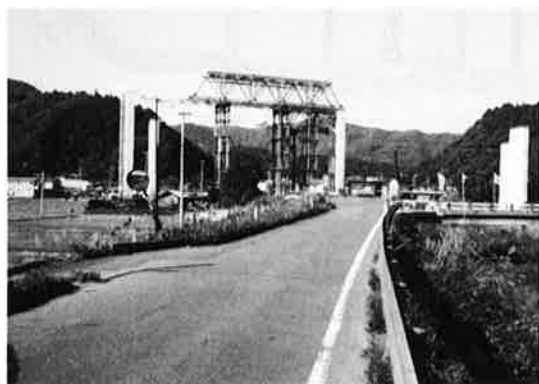
写真-4 5パネル架設完了
