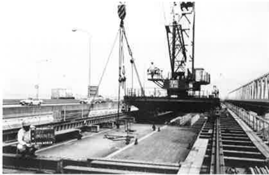
写真-4 ジブクレーン
