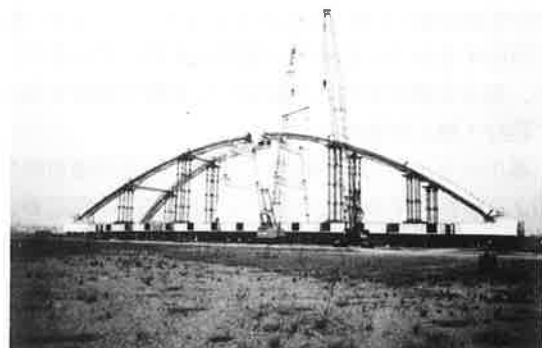
写真-2 アーチ組立
