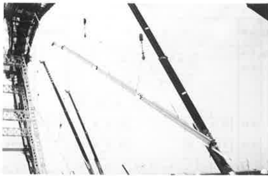
写真-4 ケーブルの架設
