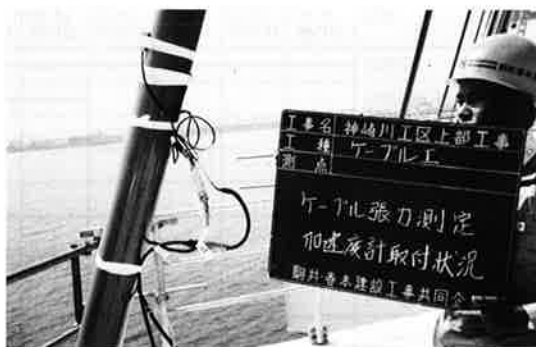
写真-8 加速度計取付
