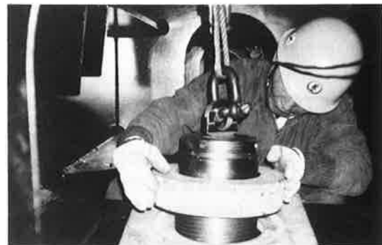
写真-8 定着ナットのセット
