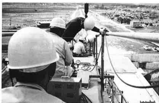
写真-11 張力調整作業
