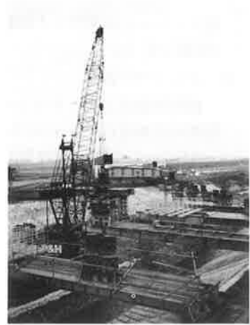
写真-1 下弦材、床組の架設
