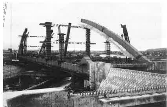
写真-2 アーチ材の架設
