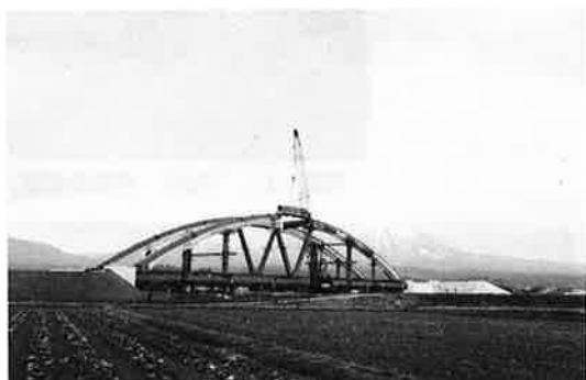
写真-3 アーチ材の閉合
