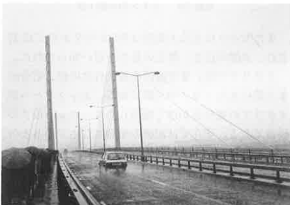
写真-9 ケソック橋
