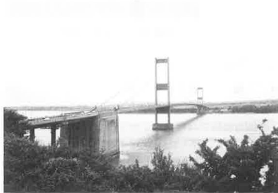
写真-11 セーバン橋
