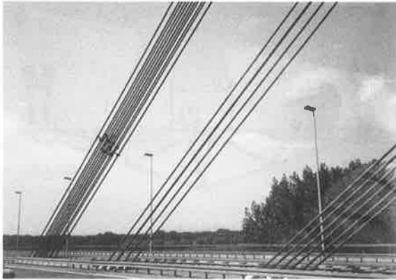
写真-3 ケーブルダンパー
