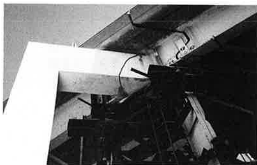
写真-1 Dan Ryan 高架橋
