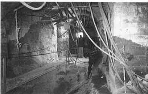
写真-8 Manhattan 橋 Anchorage 交換工事中
