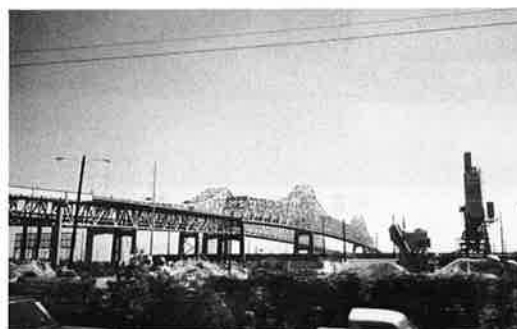
写真-12 Greater New Orleans 橋
