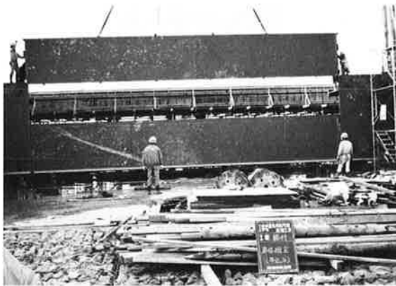
写真-2 扉体吊込
