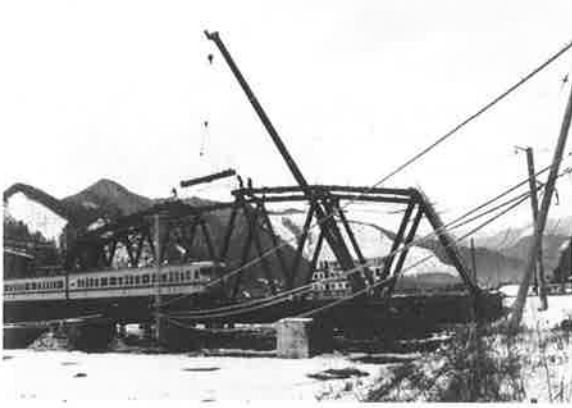
写真-1 トラス桁組立作業状況
