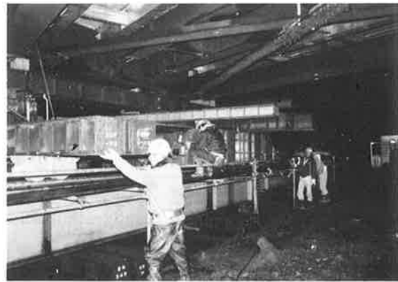
写真-4 横取り作業状況
