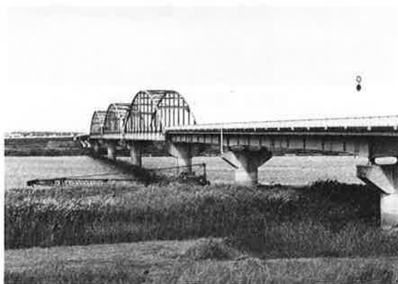
写真-9 神崎大橋
