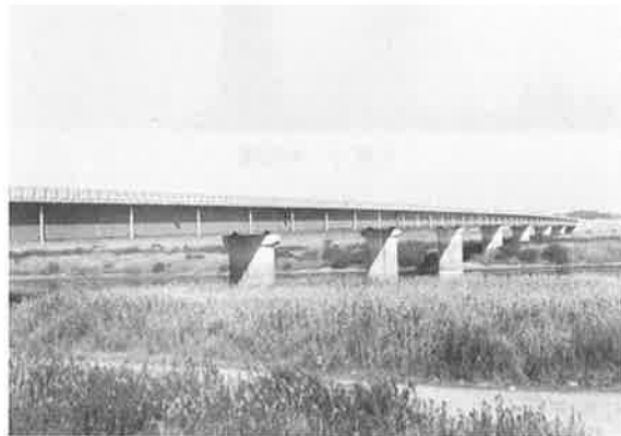
写真-5 新大利根橋
