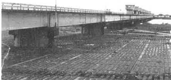
写真-13 利根川大橋
