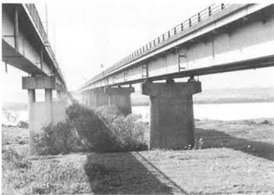
写真-3 境大橋 同歩道橋
