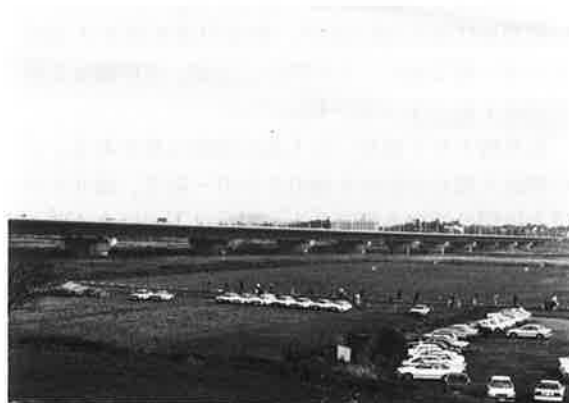
写真-6 大利根橋
