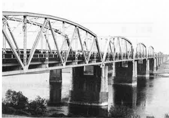
写真-1 利根川橋 上り線
