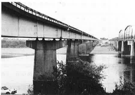
写真-2 利根川橋 下り線
