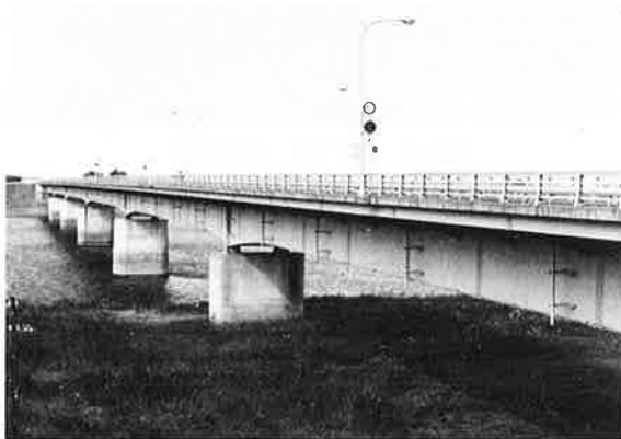
写真-10 常総大橋
