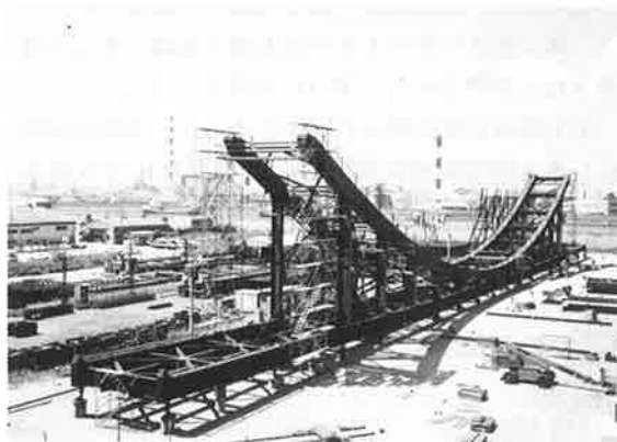
写真-1 仮組状態
