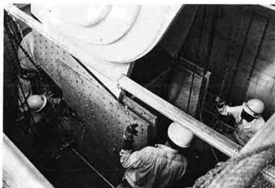
写真-13 エンドリンク沓とジョイント
