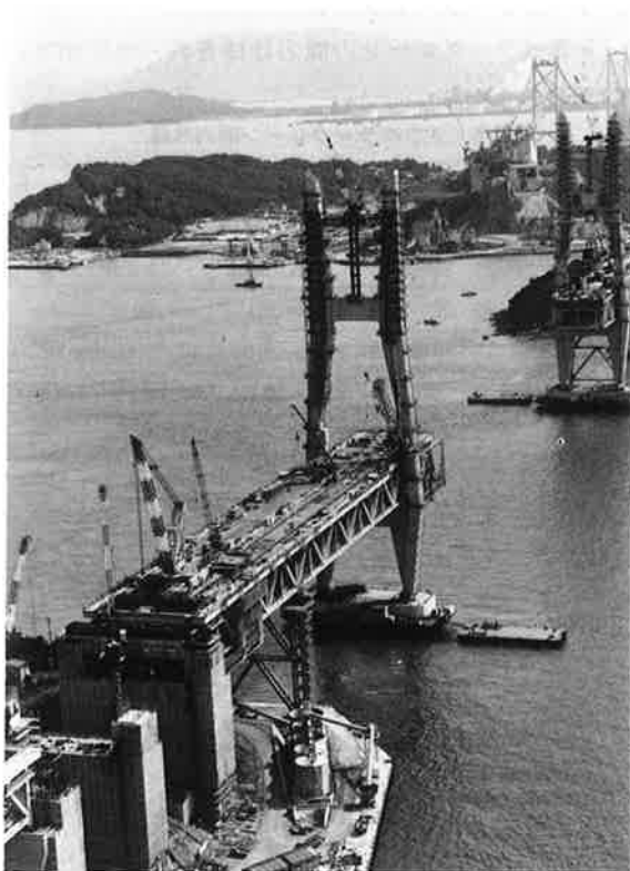
写真-17 最終部材架設 (その2)
