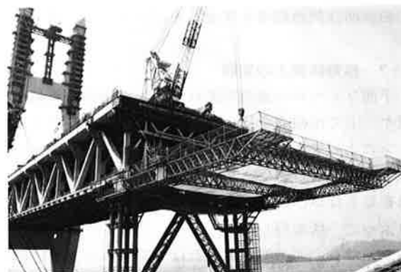
写真-20 移動防護工架設その2
