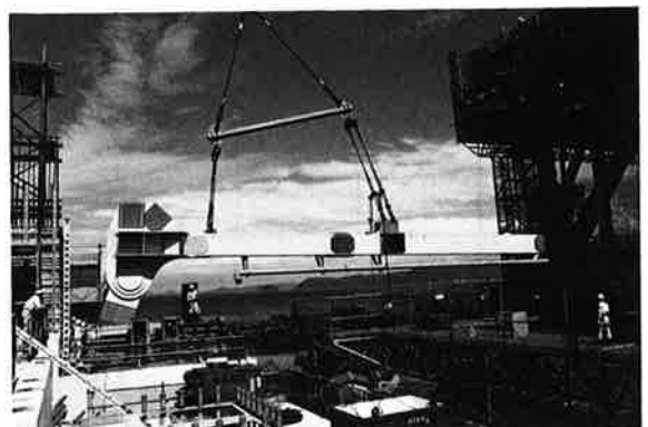
写真-10 下弦材架設
