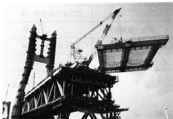
写真-19 移動防護工架設その1
