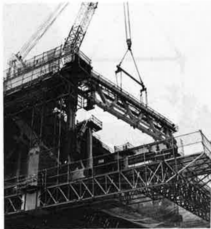
写真-8 床トラス上部面材架設
