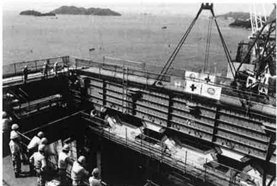
写真-16 最終部材架設 (その1)
