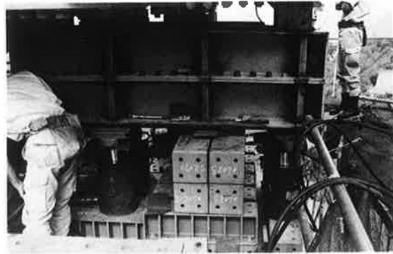
写真-12 1Pジャッキ扛上
