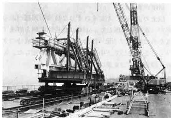
写真-7 床トラス上部面材台車搭載図
