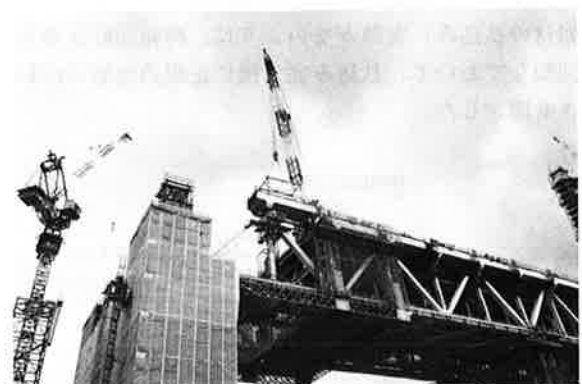
写真-11 上弦材架設
