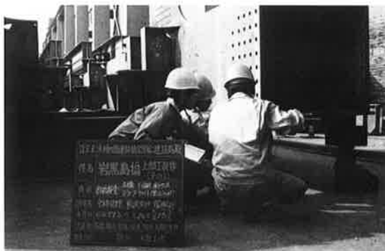
写真-8 部材長の測定
