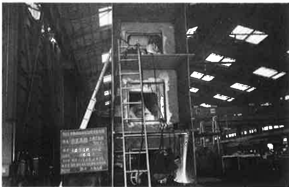
写真-2 溶接作業
