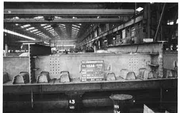
写真-7 組立作業
