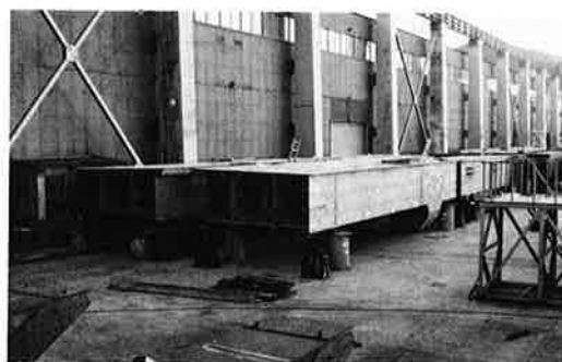
写真-1 溶接完了部材
