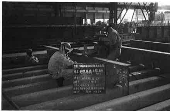
写真-6 組立作業
