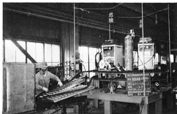
写真-5 溶接機受台
