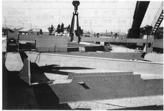
写真-8 主構側取合確認
