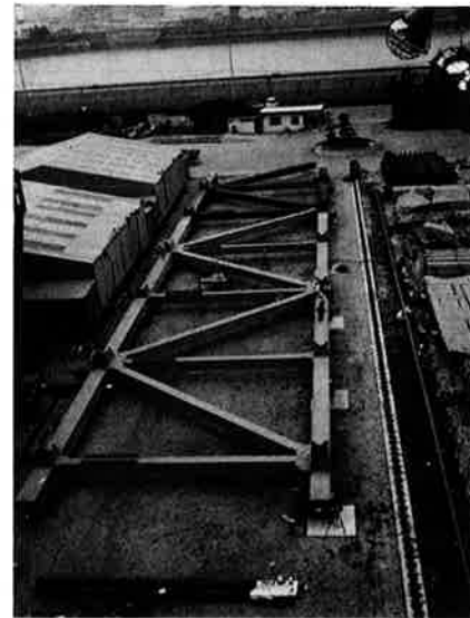
写真-5 主構平面仮組立
