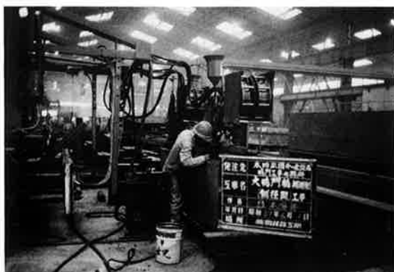
写真-3 かど継手溶接状況
