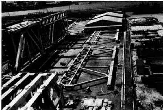
写真-6 横トラス平面仮組立
