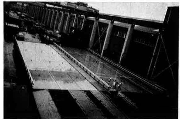
写真-7 鋼床版仮組立
