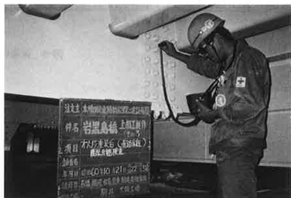
写真-7 乾燥塗膜厚測定(上塗)
