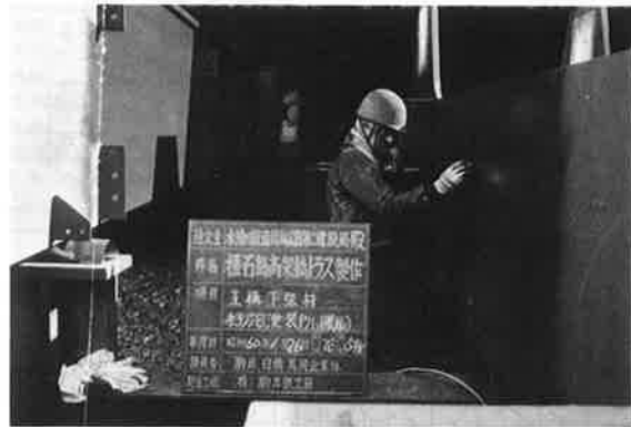
写真-6 ウェット膜厚測定(下塗)
