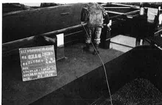
写真-4 下塗作業中
