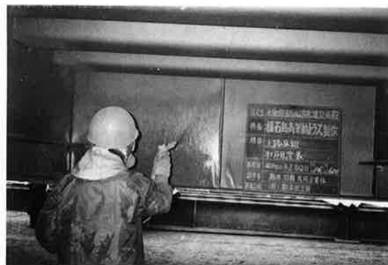
写真-3 厚膜型無機シンクリッチペイント塗装作業中
