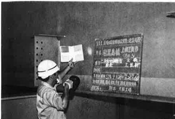
写真-2 二次プラスト後の検査
