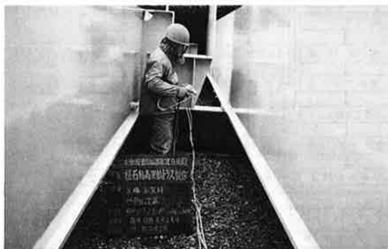
写真-5 上塗作業中
