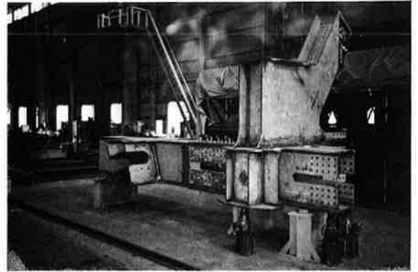
写真-9 ハンガーブラケットと水平トラスの仮組立状態
