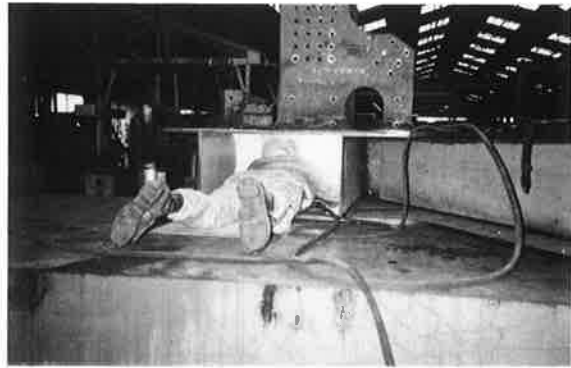
写真-8 溶接作業状況
