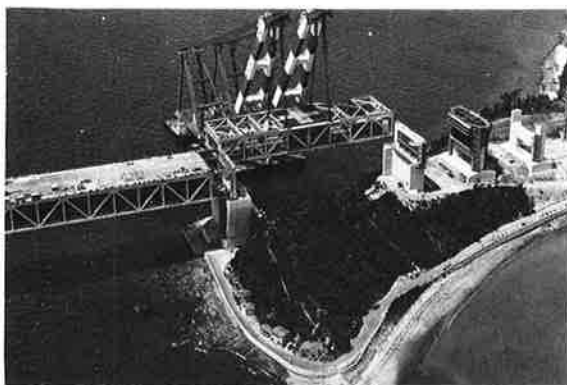
写真-13 大ブロック架設状況
