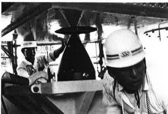
写真-14 支承ガイドへの挿入状況
