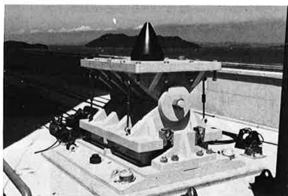
写真—11 支承の据付
