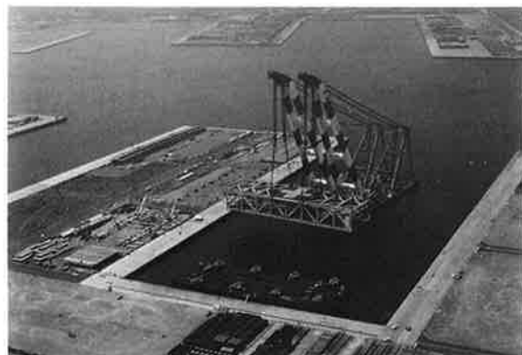
写真-6 台船に積込中
