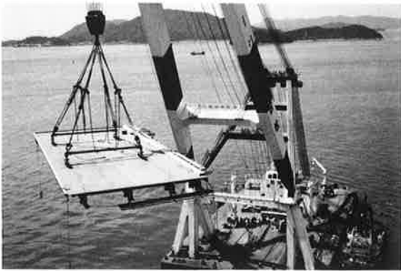
写真—15 鋼床版の架設
