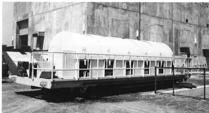
写真-5 ゲート全景 (仮置状況)
