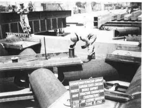
写真-3 クロスブレーシングのピン部
