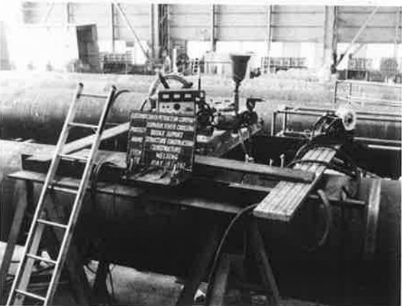
写真-2 脚の突合溶接
