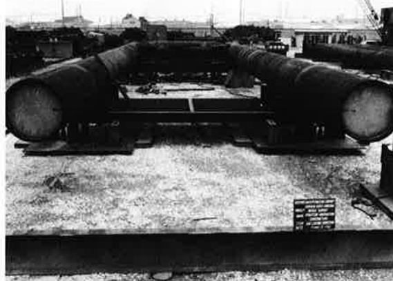
写真-5 仮組立の状況
